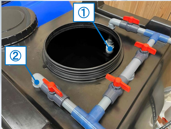
貯水タンク流入口(2カ所)
