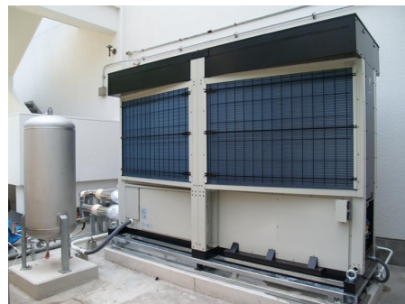
ヒートポンプ式 モジュールチラー
