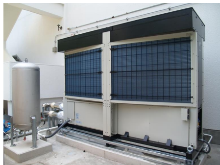
ヒートポンプ式 モジュールチラー
