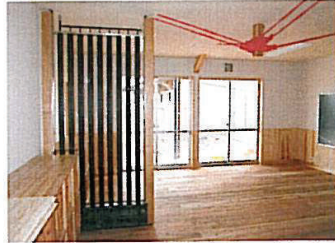
熱源スペース
