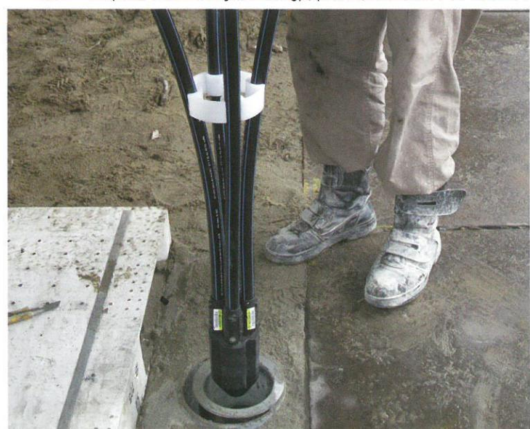
分岐管方式の地中熱交換器
