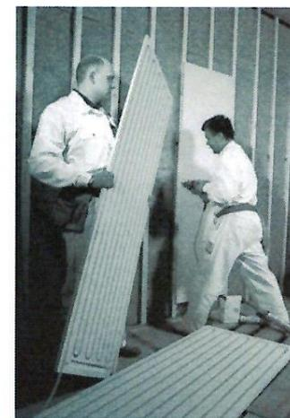
図23 混合管を仕込んである石工繊維板を用いた壁暖房
