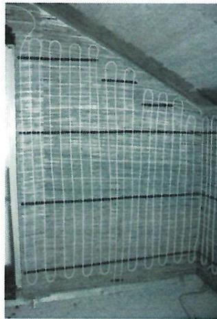
図21 ポリプロピレン管を塗り下地材であるアシボードに留めた壁暖房
