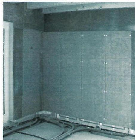
図22 配管を仕込んだ土パネルからなる壁暖房
