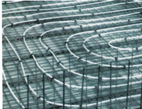
図 27 ソーラー熱を用いたコンクリート蓄熱
